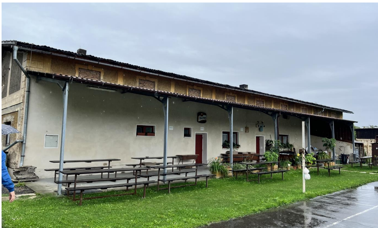
Obrázek 16: Fotografie pohostinství + požární zbrojnice
